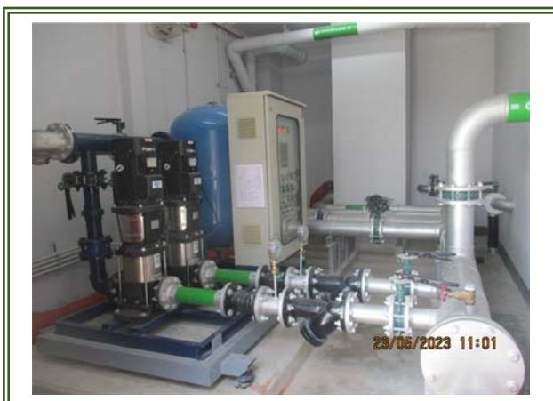
รูปที่ 2-14 ระบบสูบน้ำภายในอาคาร
