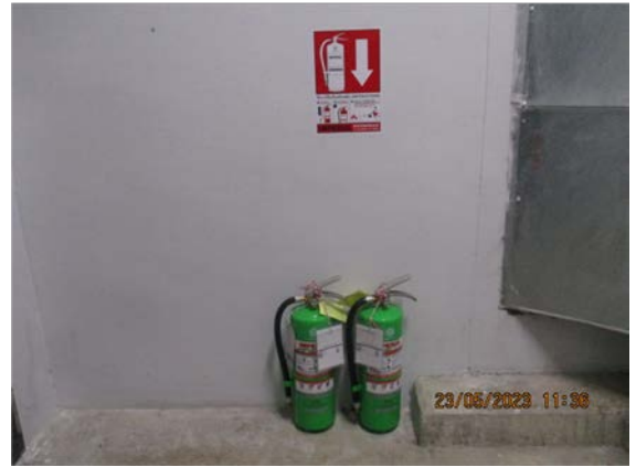
รูปที่ 2-41 ถังดับเพลิงบริเวณห้องหม้อแปลงไฟฟ้า
