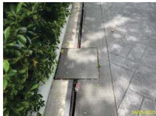
รางระบายน้ำและบ่อพักน้ำรอบโครงการ
