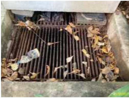
บ่อสุดท้ายพร้อมตะแกรงดักขยะ
