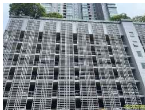
ช่องเปิดระบายอากาศชั้นจอดรถ
