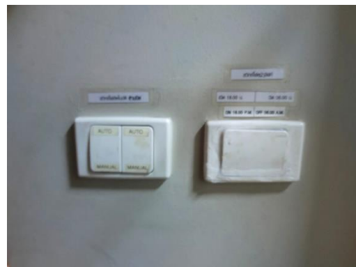
รูปที่ 14 สวิตช์ ทำงานเปิด- ปิด ไฟฟ้า บริเวณที่ใช้ งานแบ่งช่วงเวลา
