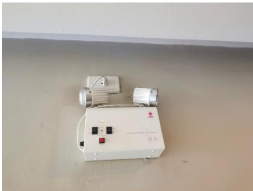
รูปที่ 27 ไฟฟ้าฉุกเฉิน
