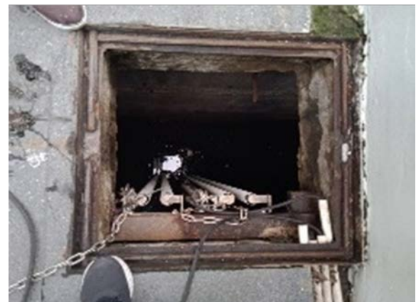
รูปที่ 2-10 การสูบน้ำตะกอน
