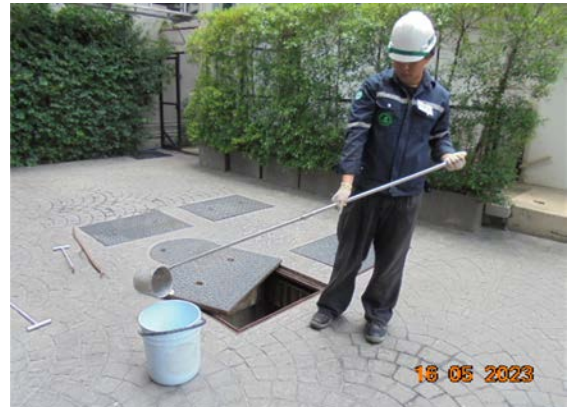
รูปที่ 3-6 การเก็บตัวอย่างคุณภาพน้ำทิ้ง บริเวณบ่อพักน้ำสุดท้ายก่อนระบายออกระบบ ระบายน้ำทิ้งสาธารณะ
