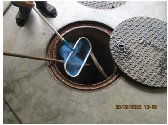
รูปที่ 2-12 การตักกากไขมัน
