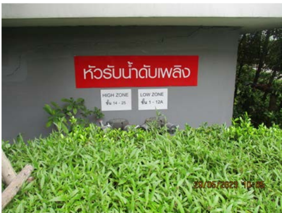
รูปที่ 2-38 ห้รับน้ำดับเพลิง
