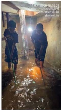
รูปที่ 2-18 การล้างถังสำรองน้ำ
