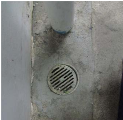
รูปที่ 2-58 ตะแกรงครอบรูท่อระบายน้ำ
