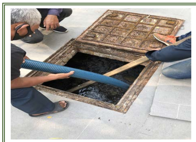
รูปที่ 2-13 สุ่มตะกอนส่วนเกินจากระบบบำบัดน้ำเสีย
