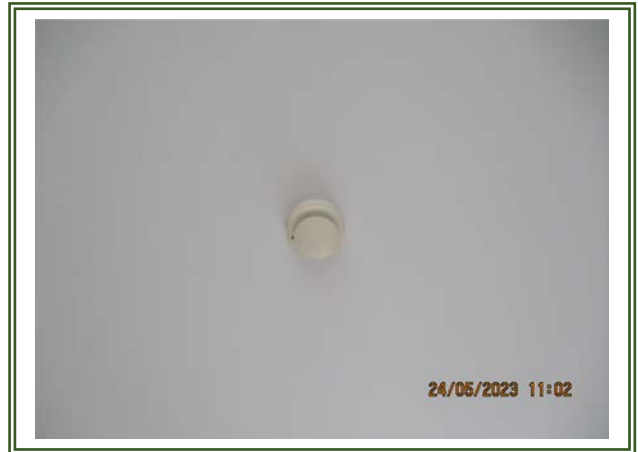
รูปที่ 2-75 เครื่องตรวจจับควัน (Smoke Detector)
