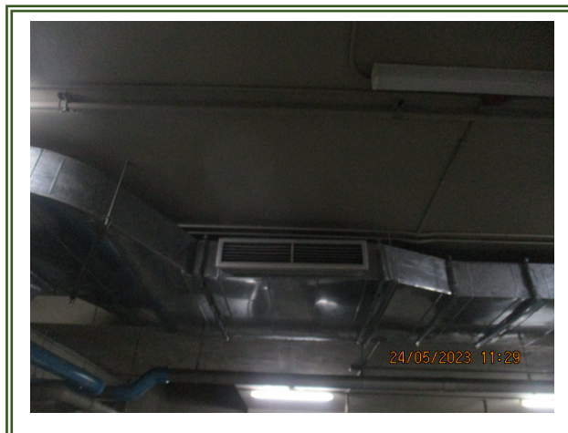
รูปที่ 2-6 ระบบระบายอากาศบริเวณลานจอดรถชั้นใต้ดิน
