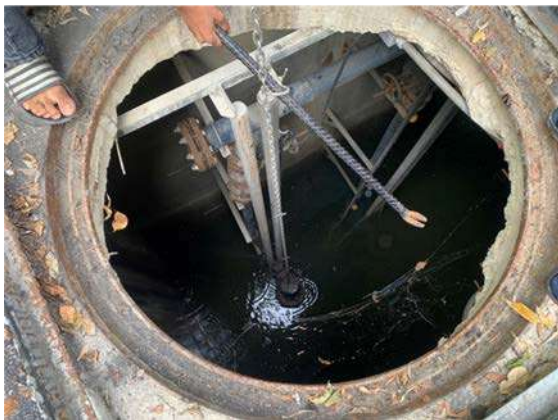
รูปที่ 2-31 เครื่องสูบน้ำในบ่อหนองน้ำ
