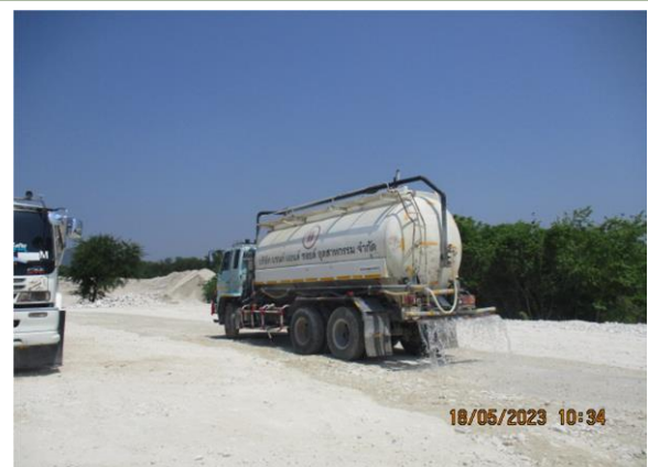
รูปที่ 3-30 การฉีดพรมน้ำบนถนนในเส้นทางขนแร่
