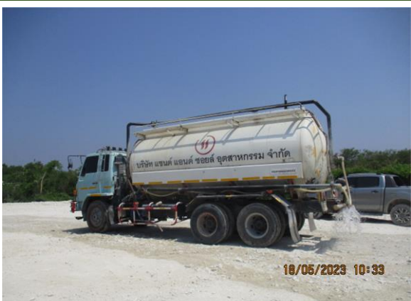
รูปที่ 3-29 การฉีดพรมน้ำบนถนนในเส้นทางขนแร่
