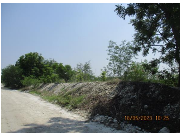
รูปที่ 3-11 เปลือกดินและเศษดินน้ำกลับมากถมปรับพื้นที่ บริเวณบ่อขุดเหมือง
