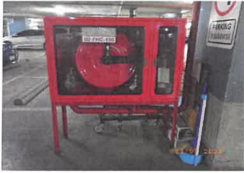
ตู้เก็บสายส่งน้ำดับเพลิง
