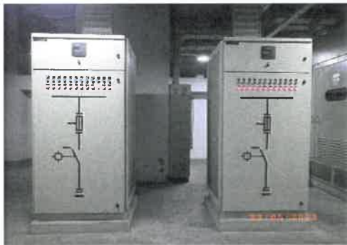
รูปที่ 2- 36 อุปกรณ์ควบคุมค่าเพาเวอร์แฟกเตอร์
