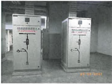
รูปที่ 2-36 อุปกรณ์ควบคุมค่าเพาเวอร์แฟคเตอร์
