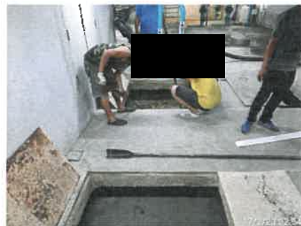
รูปที่ 2-24 การสูบลากตะกอนในถังเกรอะ
