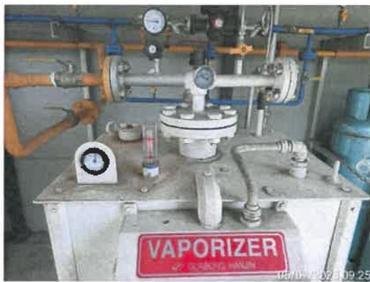
รูปที่ 2-44 อุปกรณ์ตรวจจับก๊าซบริเวณถังเก็บก๊าซหุงต้ม ของพื้นที่ส่วนกลาง
