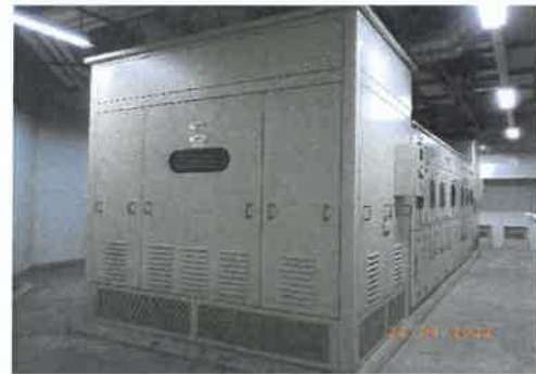
รูปที่ 2-33 หม้อแปลงไฟฟ้า
