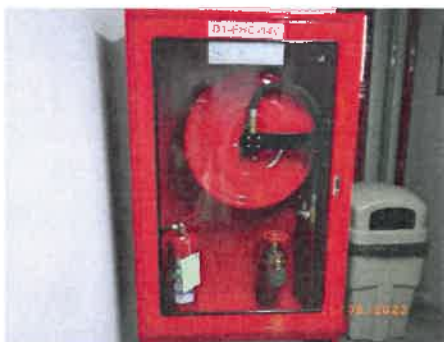
ตู้เก็บสายส่งน้ำดับเพลิง
