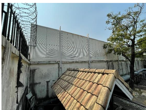
ภาพที่ 2-3 รั้วอิฐบล๊อคความสูงประมาณ 3 เมตร และเพิ่มระแนง PVC ประมาณ 2 เมตร บริเวณที่ติดกับชุมชนและวัดคุณแม่จันทร์
