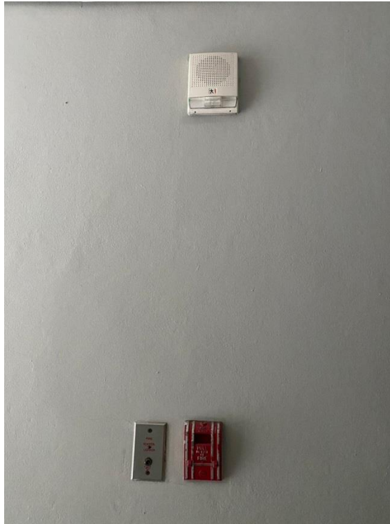
ภาพที่ 23 แสดงชุดกดแจ้งเหตุ และสัญญาณแจ้งเหตุเพลิงไหม้
