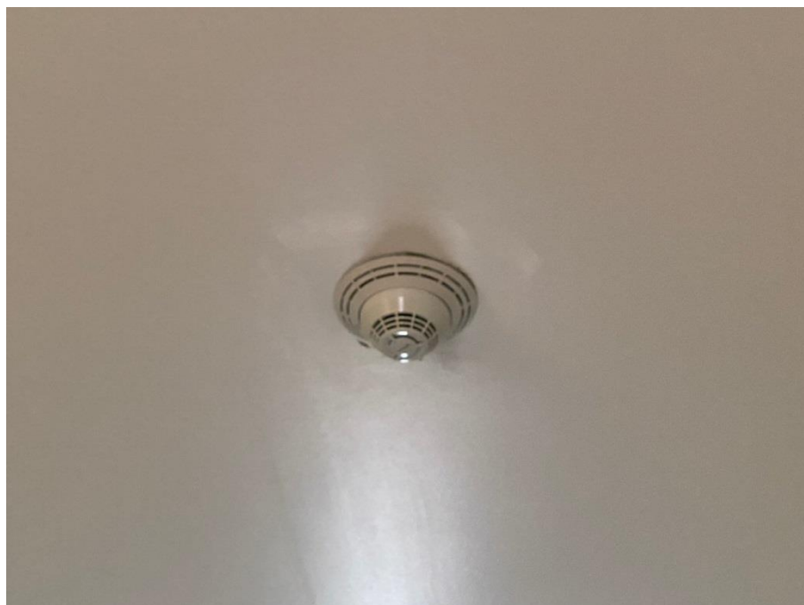
ภาพที่ 16 แสดงเครื่องตรวจจับควัน (Smoke detector)
