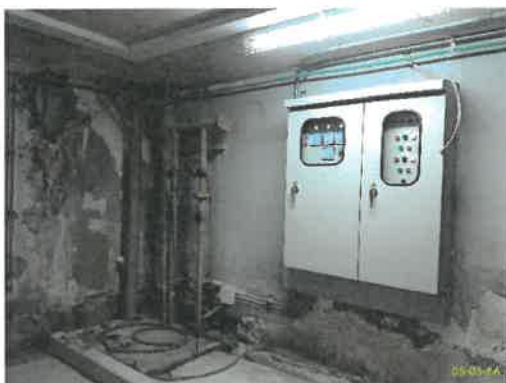
เครื่องสูบน้ำ และตู้ควบคุม การระบายน้ำชั้นใต้ดินอาคาร B ท่อระบายน้ำภายในอาคาร (ต่อ)
