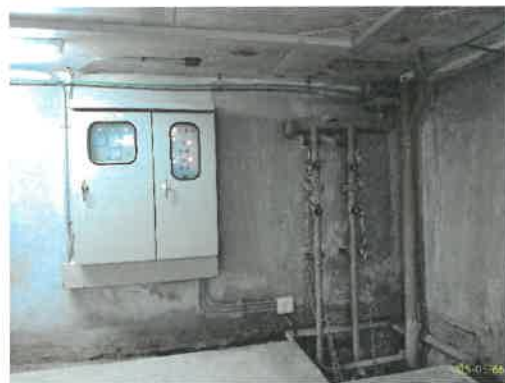
เครื่องสูบน้ำ และตู้ควบคุม การระบายน้ำชั้นใต้ดินอาคาร B ท่อระบายน้ำภายในอาคาร (ต่อ)
