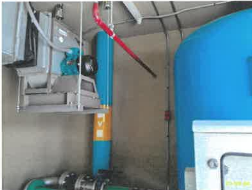
ชั้นดาดฟ้า ปั๊ม และถังเก็บน้ำสำรองเพื่อการอุปโภค-บริโภค อาคาร B ภาพที่ 1.3.4-1 (ต่อ) ระบบน้ำใช้
