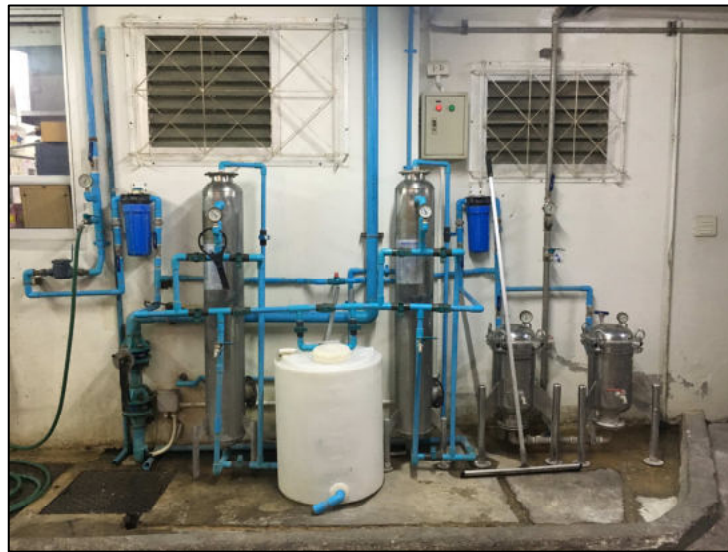
ภาพที่ 2-11 ระบบกรองน้ำเพื่อใช้บริโภค
