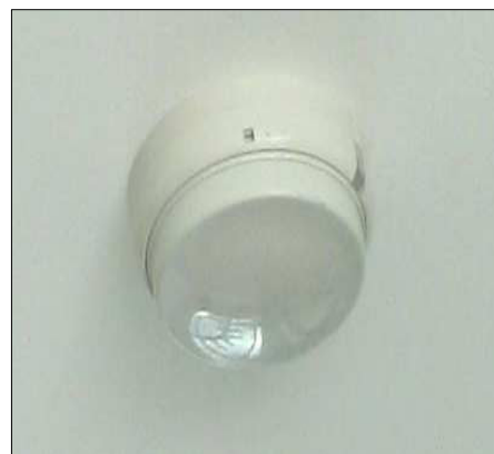
ภาพที่ 1-17 เครื่องตรวจจับควัน และเครื่องตรวจจับความร้อน
