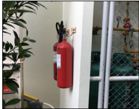
ภาพที่ 2-7 หัวรับน้ำดับเพลิง และถังดับเพลิง
