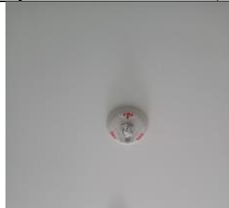
รูปที่ พ7.56 เครื่องตรวจจับความร้อน (Heat Detector)
