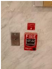
รูปที่ ๗.57 เครื่องแจ้งเหตุโดยใช่มือดึง (Fire Alarm Manual Station)
