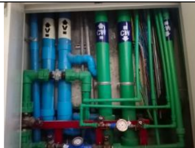
รูปที่ ผ7.52 ระบบท่อยืน (Stand Pipe)
