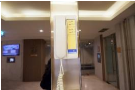
รูปที่ ผ7.59 โทรศัพท์ฉุกเฉิน (Telephone Jack)
