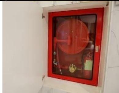
รูปที่ ผ7.54 ตู้เก็บสายฉีดน้ำดับเพลิงพร้อมอุปกรณ์ (FHC)
