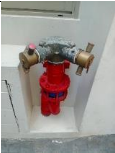
รูปที่ ผ7.53 หั้วรับน้ำดับเพลิงภายนอกอาคาร (FDC)
