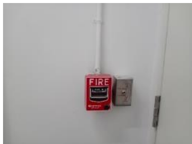
รูปที่ ๗.57 เครื่องแจ้งเหตุโดยใช่มือดึง (Fire Alarm Manual Station)
