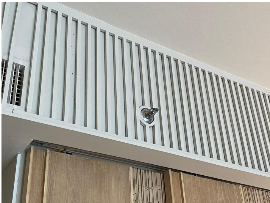
ภาพที่ 30 แสดงหัวกระจายน้ำดับเพลิง (Sprinkler)
