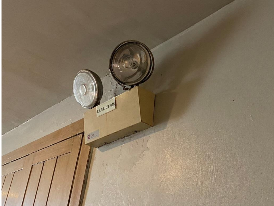
ภาพที่ 31 แสดงไฟส่องสว่างฉุกเฉินบริเวณทางเดิน
