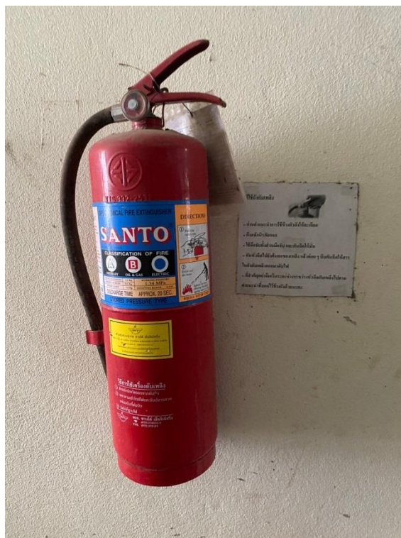
ภาพที่ 18 แสดงถังดับเพลิงชนิดผงเคมีแห้งและวิธีการใช้งาน
