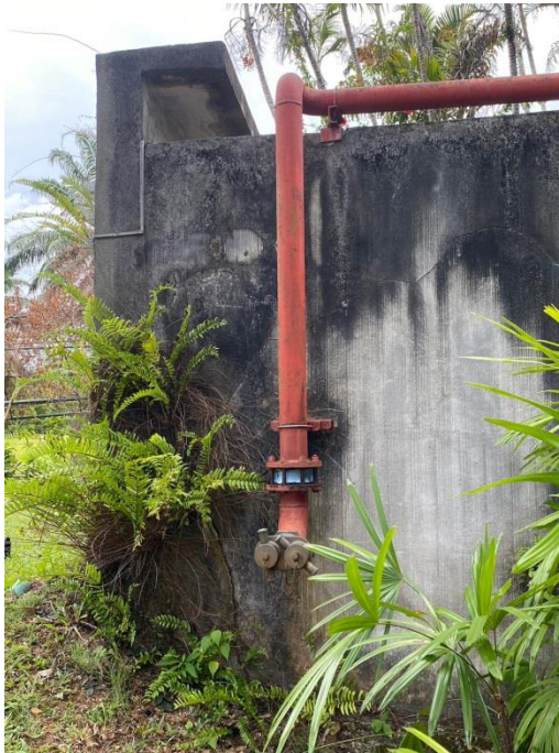
ภาพที่ 19 แสดงบ่อเก็บน้ำสำรองสำหรับดับเพลิง และหัวจ่ายน้ำดับเพลิง
