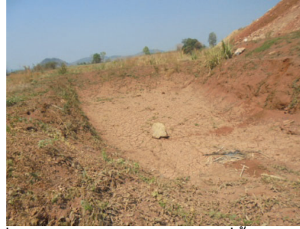
รูปที่ 2-58: บ่อดักตะกอน ในสถานที่ทิ้งดินหรือเก็บ มูลดินทรายใบอนุญาตที่ 3/2562
