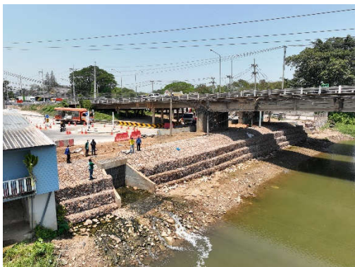
ภาพที่ 5.2.5-1 ผลการตรวจสอบการพังทลายของดิน บริเวณพื้นที่ก่อสร้างบ่อตกตะกอน ริมตลิ่งแม่น้ำแม่กลอง
