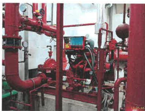
เครื่องสูบน้ำดับเพลิงชั้น 51
