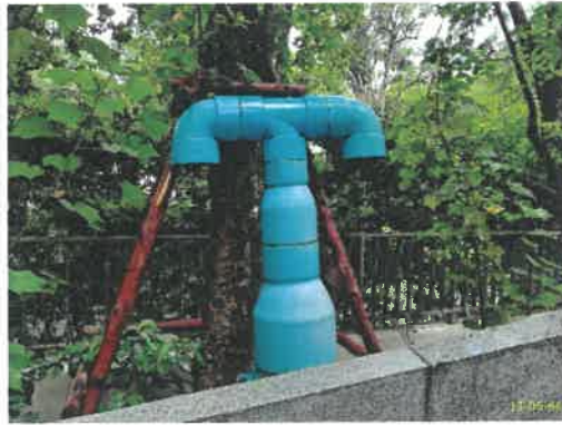
บ่อดินบำบัดมีเทน และ Aerosol ภาพที่ 1.3.5-1 (ต่อ) ระบบบำบัดน้ำเสียโครงการ
