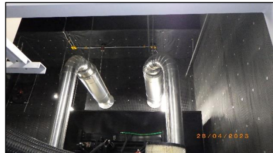
ช่องเปิดระบายไอเสียจากห้องเครื่องกำเนิดไฟฟ้า
