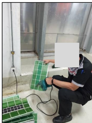
รูปที่ 2-35 การทำความสะอาดเครื่องปรับอากาศ
