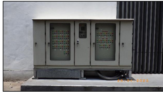
ระบบมิเตอร์ไฟฟ้าสำหรับระบบบำบัดน้ำเสีย
