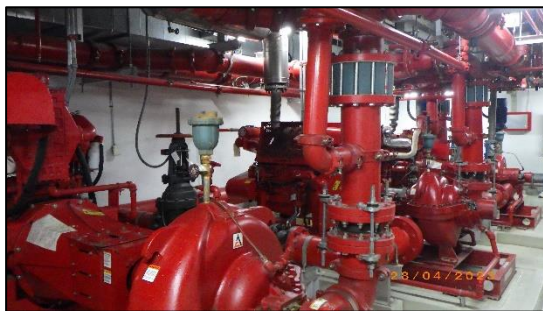
ระบบเครื่องสูบน้ำดับเพลิง
