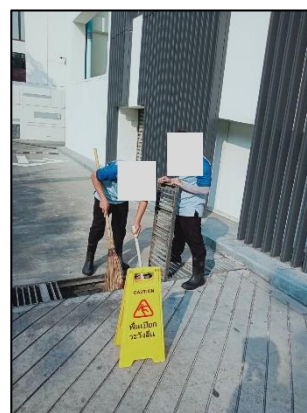
รูปที่ 2-11 การทำความสะอาดและลอกท่อระบายน้ำ
