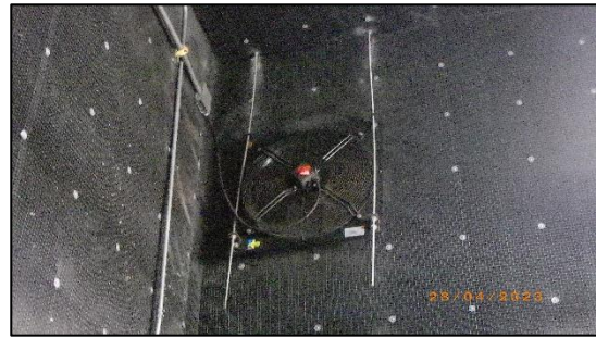
พัดลมระบายอากาศภายในห้องเครื่องกำเนิดไฟฟ้าสำรอง
