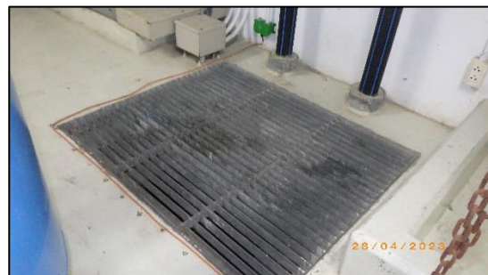
รูปที่ 2-10 ตะแกรงครอบท่อระบายน้ำ
