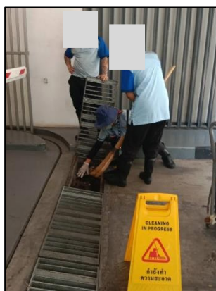
รูปที่ 2-11 การทำความสะอาดและลอกท่อระบายน้ำ
