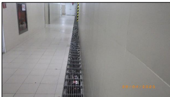
รูปที่ 2-10 ตะแกรงครอบท่อระบายน้ำ
