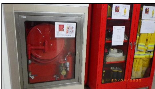
ตู้เก็บสายฉีดน้ำดับเพลิงพร้อมอุปกรณ์
