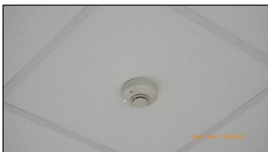
เครื่องตรวจจับควัน (Smoke Detector)
