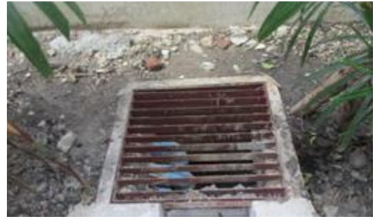
รูปที่ 15 ตะแกรงดักขยะ
