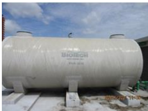
รูปที่ 31 น้ำสำรองสำหรับระบบดับเพลิง
