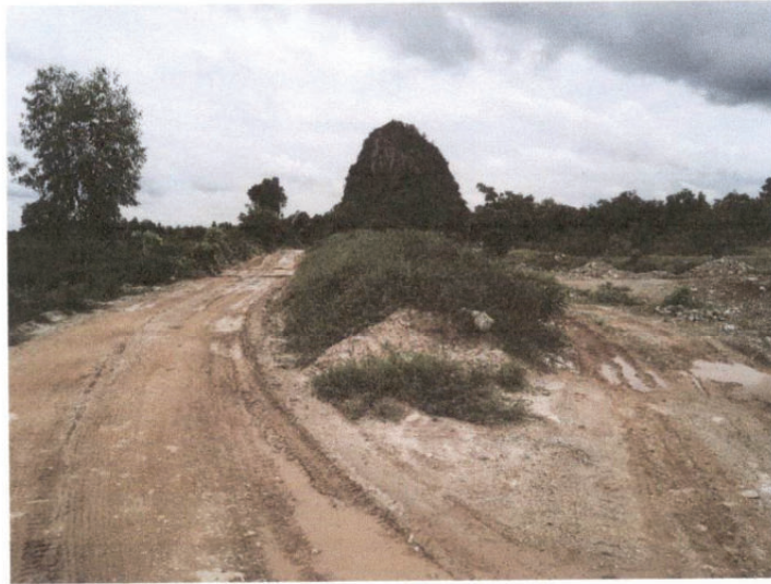
รูปที่ 5 แสดงคันทำนบกั้น โดยที่ใช้เศษหินและดินปรับแต่งเป็นแนวคันทำนบกั้น บริเวณด้านตะวันออกทางเข้าโครงการฯ
