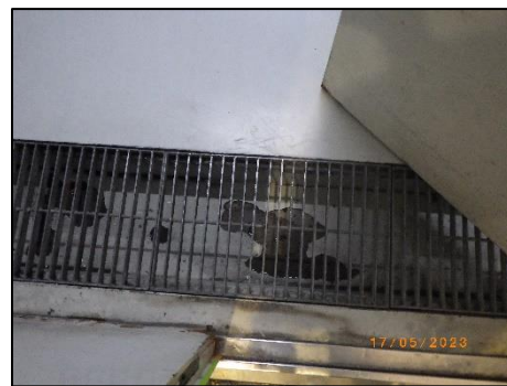
รูปที่ 2-18 ท่อรวบรวมน้ำจากการล้างห้องพักมูลฝอย
