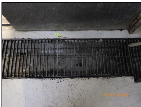
รูปที่ 2-18 ท่อรวบรวมน้ำจากการล้างห้องพักมูลฝอย
