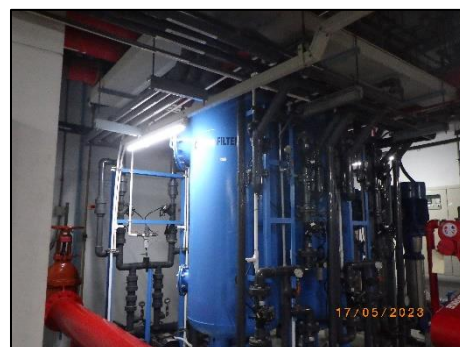
รูปที่ 2-11 ระบบปรับปรุงคุณภาพน้ำ (Recycle Water)
