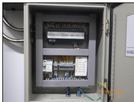
รูปที่ 2-24 การติดตั้งเครื่องปรับระดับแสงสว่าง (Dimmer)
