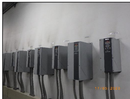
รูปที่ 2-28 อุปกรณ์ปรับรอบความเร็วมอเตอร์ VSD
