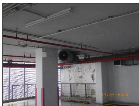
รูปที่ 2-45 พัดลมดูดอากาศภายในอาคารจอดรถ
