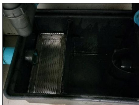
รูปที่ 2-7 การตรวจสอบถังตกไขมันและตกไขมัน
