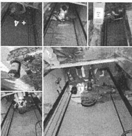
ภาพถ่ายที่ 2.2-25 การซ่อมผนังรูปลงลิฟต์
