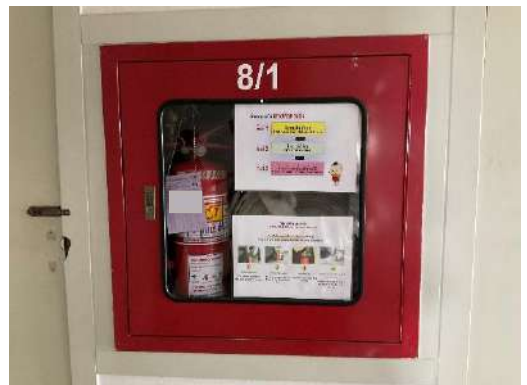
ภาพที่ 2.2-8 การตรวจสอบอุปกรณ์ดับเพลิงและป้ายแนะนำการใช้งานอุปกรณ์ดับเพลิง
