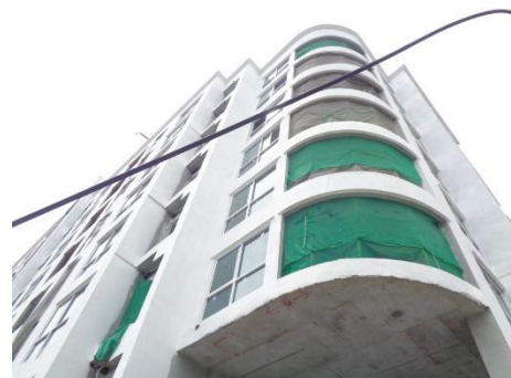
ภาพที่ 2.2-5 การปิดคลุมตัวอาคาร
