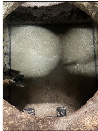
การสูบล้างสิ่งปฏิกูล รูปที่ 2.2-3 ระบบบำบัดน้ำเสียและสิ่งปฏิกูล (ต่อ)
