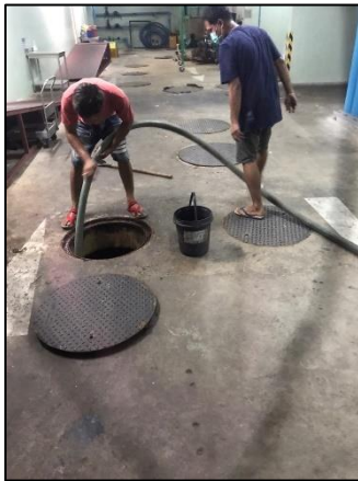
การสูบล้างสิ่งปฏิกูล รูปที่ 2.2-3 ระบบบำบัดน้ำเสียและสิ่งปฏิกูล (ต่อ)
