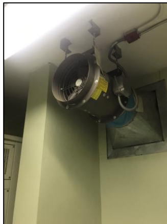
ระบบระบายอากาศในห้องไฟฟ้า
