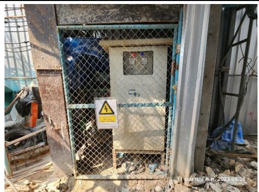
รูปที่ 28 อุปกรณ์และเครื่องจ่ายไฟฟ้า
