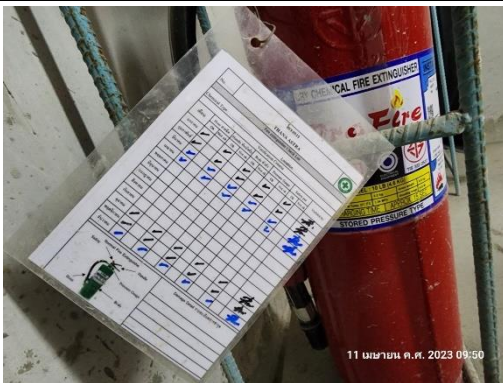
รูปที่ 23 ป้ายตรวจสอบสภาพพร้อมใช้งานถังดับเพลิง
