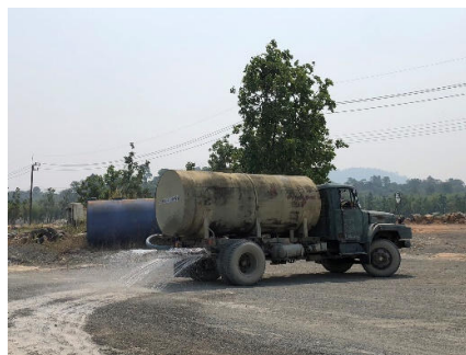
รูปที่ 2-26: การฉีดพรมน้ำบริเวณเส้นทางขนส่งแร่
