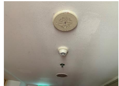
smoke detector และ sprinkler fire
