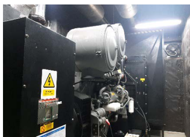
ภาพที่ 1.3-13 เครื่องกำเนิดไฟฟ้าสำรองขนาด 650 KVA
