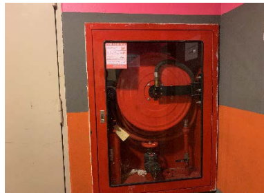
ตู้เก็บสายดับเพลิงพร้อมอุปกรณ์
