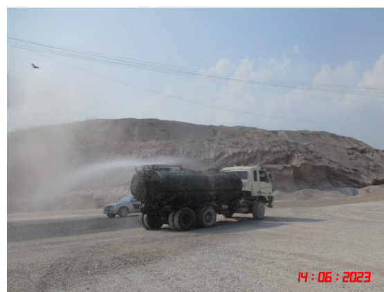
รูปที่ 11 การฉีดพรมน้ำบริเวณโรงโม่หิน และเส้นทางลำเลียงหิน
