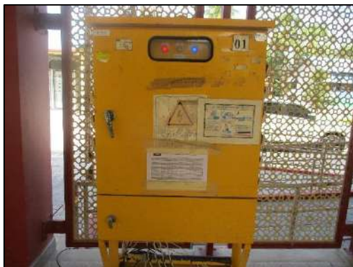
รูปที่ 2-19 ติดตั้งตู้ควบคุมไฟฟ้าในพื้นที่ก่อสร้าง พร้อมการตรวจเช็คอุปกรณ์ไฟฟ้าที่ใช้ในการทำงาน
