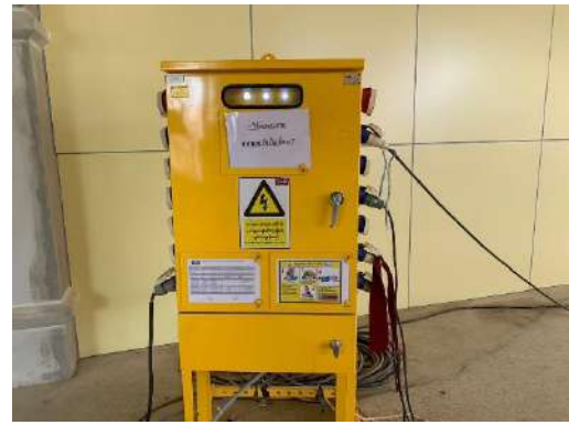
รูปที่ 2-19 ติดตั้งตู้ควบคุมไฟฟ้าในพื้นที่ก่อสร้าง พร้อมการตรวจเช็คอุปกรณ์ไฟฟ้าที่ใช้ในการทำงาน
