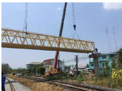
รูปที่ 2-4 งานติดตั้งโครงเหล็กทางเดินสะพานลอย
