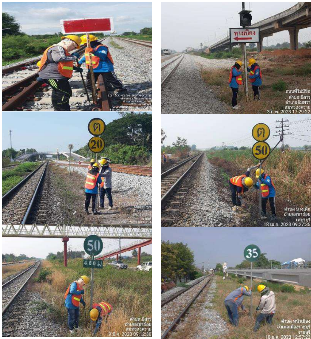
รูปที่ 2-44 ติดตั้งป้ายสัญญาณตามข้อกำหนด ขตร. ของการรถไฟฯ
