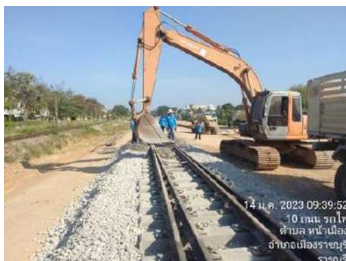
รูปที่ 2-2 งานลงหิน Ballast วางหมอนหมอนคอนกรีต วางรางรถไฟ
