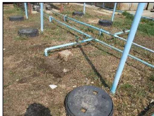
รูปที่ 2-26 ถังบำบัดน้ำเสียสำเร็จรูป บริเวณบ้านพักคนงาน
