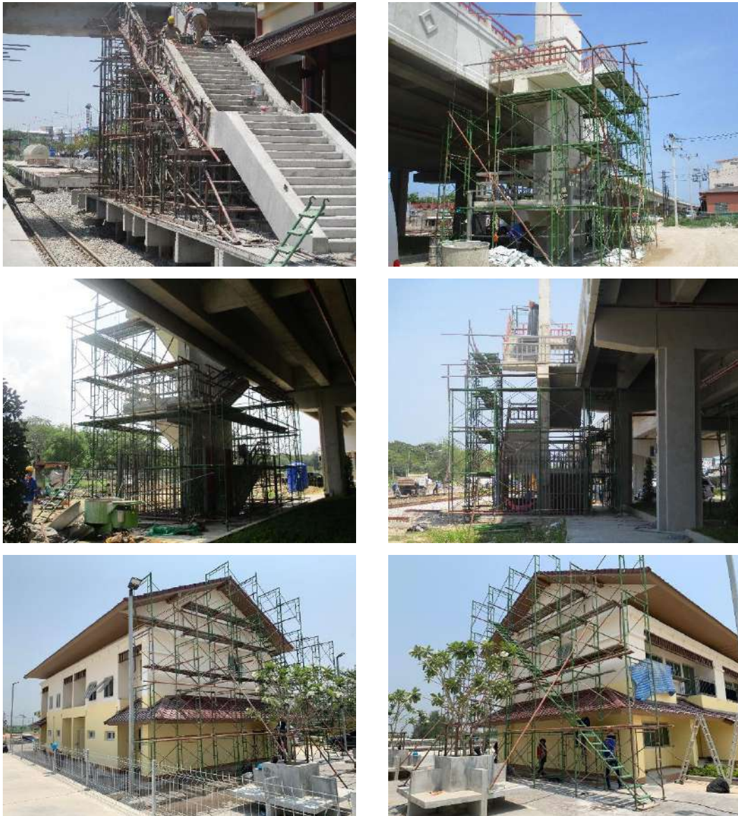
รูปที่ 2-32 การติดตั้งบันได นั่งร้านและราวกันตก
