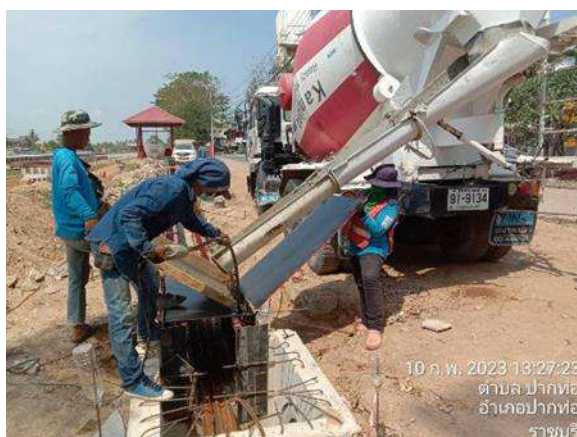
รูปที่ 1-28 งานเทคอนกรีตวางระบายน้ำรูปตัวยู บริเวณย่านสถานีปากท่อ
