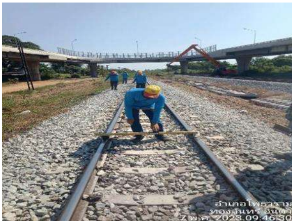
รูปที่ 1-102 งานตรวจวัดค่าความคลาดเคลื่อนรางรถไฟ กม.88+000
