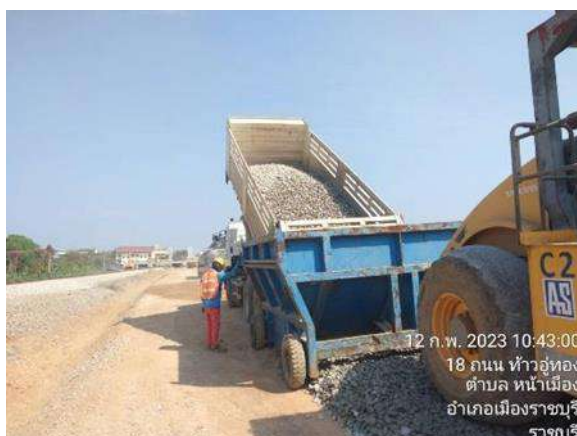
รูปที่ 1-30 งานลงหิน Ballast วางหมอนหมอนคอนกรีต
