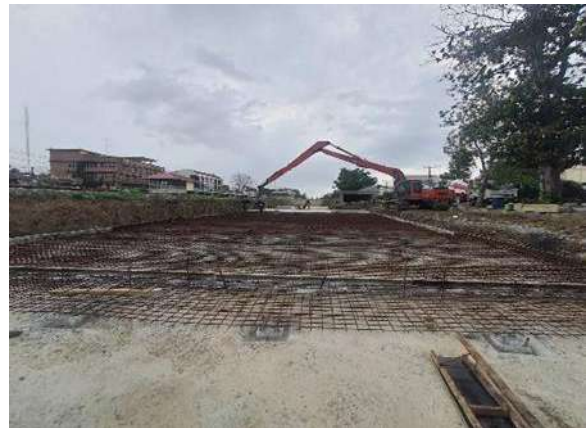
รูปที่ 1-129 งานเทคอนกรีต Bearing slab กม.82+000
