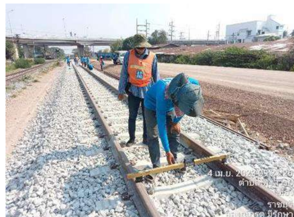
รูปที่ 1-75 งานตรวจวัดค่าความคลาดเคลื่อนรางรถไฟ กม. 101+000-
