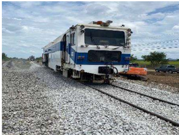
รูปที่ 1-136 งานบดอัด Ballast และจัดระดับทางรถไฟ
