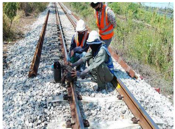
รูปที่ 1-103 งานตรวจ Ut test บริเวณย่านสถานีหนองปลาไหล
