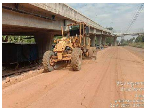
รูปที่ 1-3 งานบดอัด Sub ballast Access Road กม.79+000
