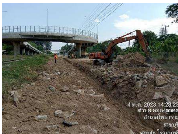
รูปที่ 1-98 งานขุดวางระบายน้ำบริเวณคันทางรถไฟ กม.78+140
