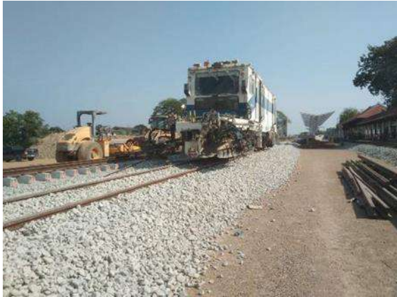
รูปที่ 1-77 งานบดอัด Ballast และจัดระดับทางรถไฟ
