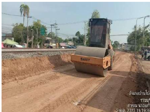
รูปที่ 1-96 งานบดอัดคันทางรถไฟ กม. 68+000 ถึง 68+100
