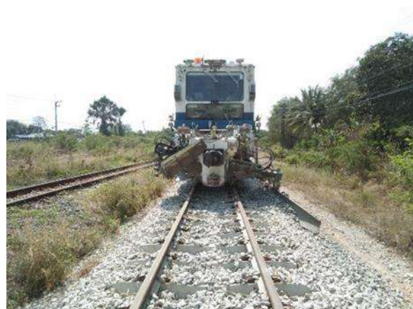
รูปที่ 1-57 งานบดอัด Ballast และจัดระดับทางรถไฟ
