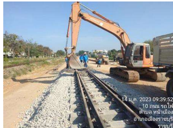
รูปที่ 1-6 งานลงหิน Ballast วางหมอนหมอนคอนกรีต วางรางรถไฟ
