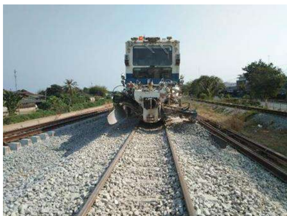
รูปที่ 1-57 งานบดอัด Ballast และจัดระดับทางรถไฟ
