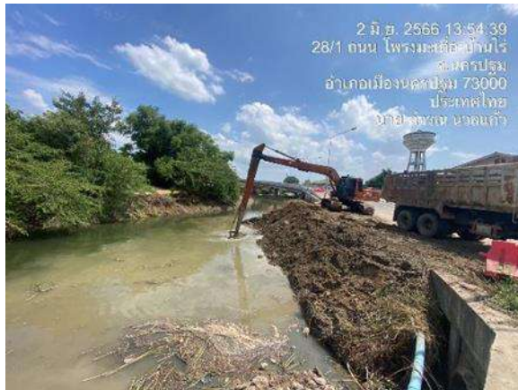
รูปที่ 1-134 งานขุดลอกคลองโพรหมเตี้ย บริเวณ Overpass กม.55+700
