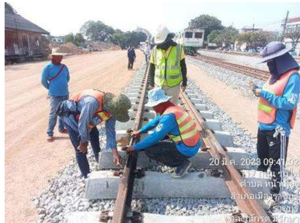
รูปที่ 1-56 งานวางหมอนคอนกรีต วางรางรถไฟ
