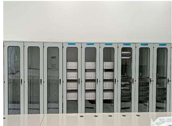
รูปที่ 1-159 ประกอบและติดตั้งอุปกรณ์อาณัติสัญญาณและโทรคมนาคมภายในอาคาร CTC (Centralized Traffic Control) และอาคาร Relay Room ณ สถานีสวนสนประดิพัทธ์
