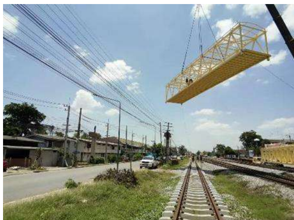
รูปที่ 1-126 งานติดตั้งโครงเหล็กสะพานลอยคนข้าม กม. 68+865
