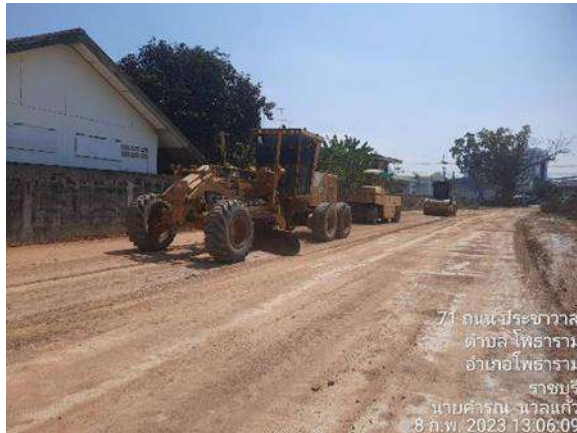
รูปที่ 1-26 งานตัดเกรด Subbase ทางขึ้น-ลงสะพาน U-Turn Road กม. 81+100
