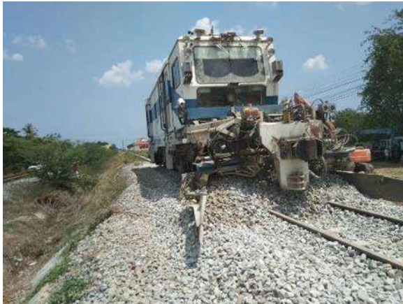
รูปที่ 1-105 งานบดอัด Ballast และจัดระดับทางรถไฟ
