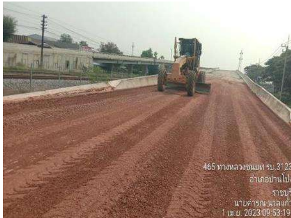
รูปที่ 1-72 งานบดอัดทางขึ้น-ลงสะพาน U-Turn Road กม. 67+600
