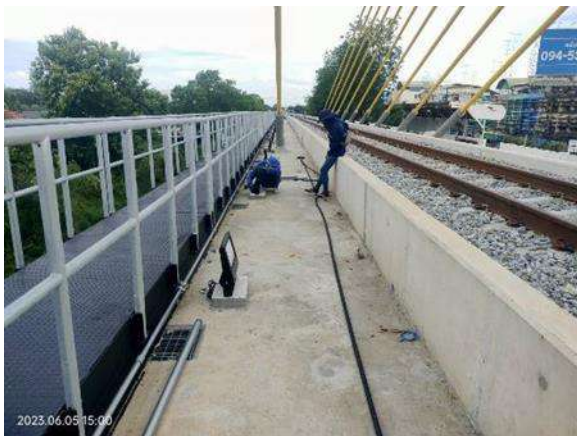
รูปที่ 1-130 งานติดตั้งไฟส่องสว่าง บริเวณสะพาน Extradosed
