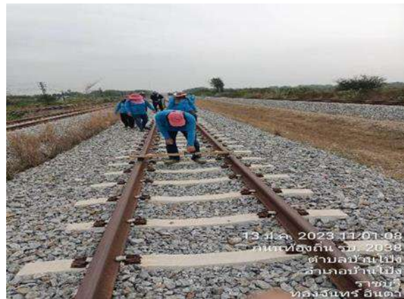
รูปที่ 1-55 งานตรวจวัดค่าความคลาดเคลื่อนรางรถไฟ กม.65+000
