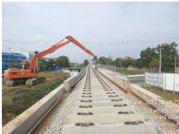
รูปที่ 1-6 งานลงหิน Ballast วางหมอนหมอนคอนกรีต วางรางรถไฟ
