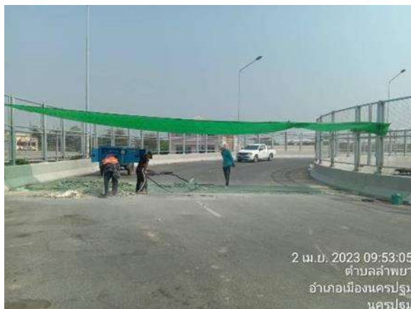
รูปที่ 1-74 งานสกัดและแต่งร่อง Expansion Joint กม. 50+596
