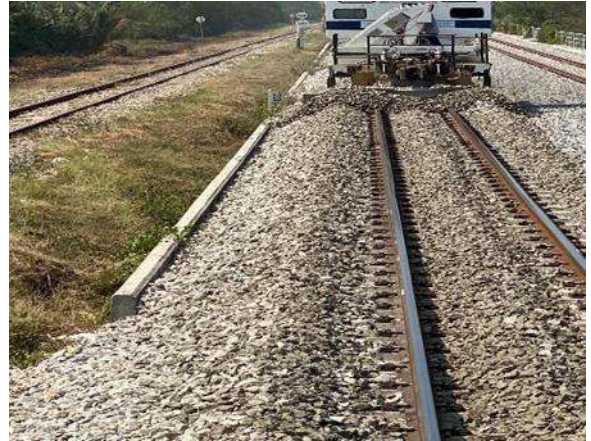
รูปที่ 1-77 งานบดอัด Ballast และจัดระดับทางรถไฟ
