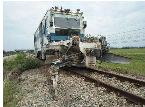
รูปที่ 1-136 งานบดอัด Ballast และจัดระดับทางรถไฟ
