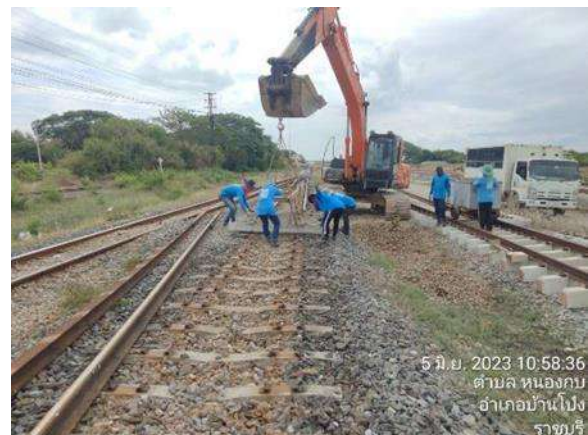
รูปที่ 1-125 งานรื้อหมอนคอนกรีตและรางรถไฟเก่า กม.64+700
