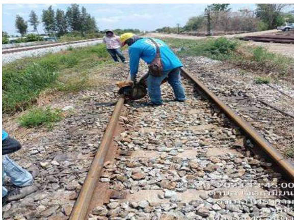
รูปที่ 1-104 งานรื้อหมอนคอนกรีตและรางรถไฟเก่า กม.89+000
