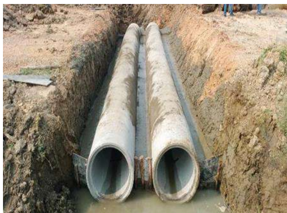
รูปที่ 1-50 งานวางท่อระบายน้ำ U-Turn Road กม.54+000
