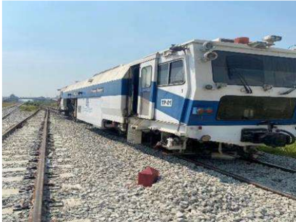
รูปที่ 1-31 งานบดอัด Ballast และจัดระดับทางรถไฟ
