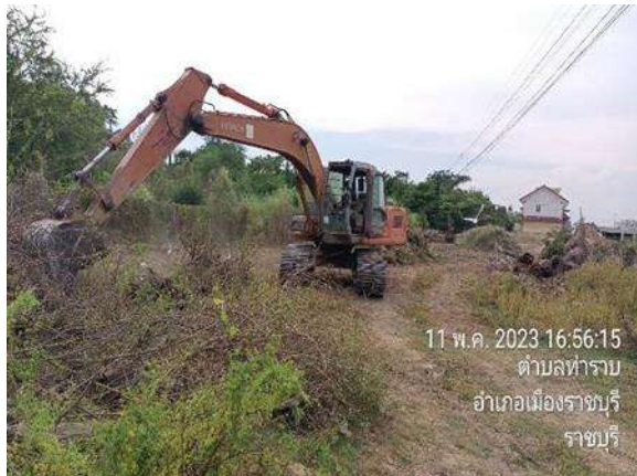
รูปที่ 1-94 งาน Clearing ปรับระดับพื้นที่สำหรับ เก็บกองหมอนและรางรถไฟเก่า บริเวณสถานีบ้านกล้วย
