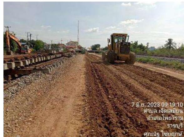
รูปที่ 1-123 งาน Mix Process Compaction วัสดุคันทาง กม.89+250 ถึง 89+450
