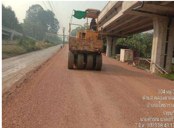
รูปที่ 1-48 งานบดอัด Access Road U-Turn กม. 79+100
