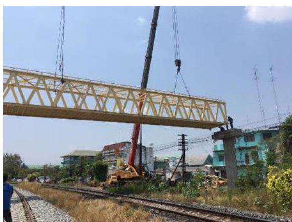
รูปที่ 1-52 งานติดตั้งโครงเหล็กทางเดินสะพานลอย กม.67+844
