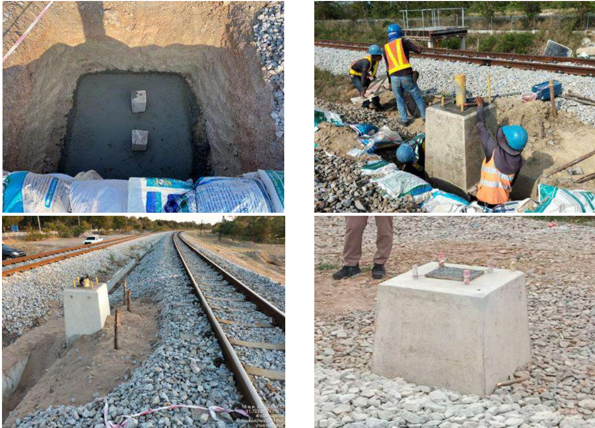
รูปที่ 1-165 งานก่อสร้างฐานเสา Signal
