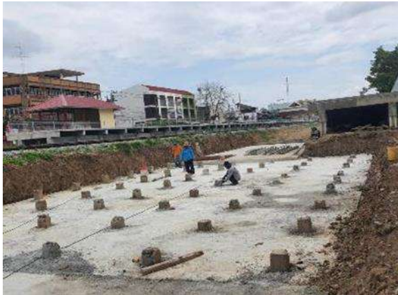
รูปที่ 1-128 งานตัดหัวเสาเข็ม Bearing slab กม. 82+000
