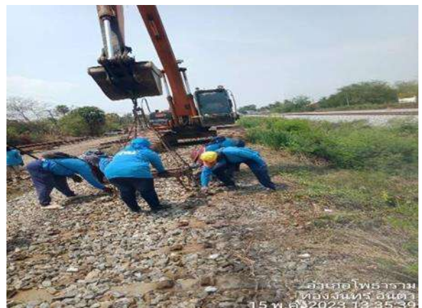
รูปที่ 1-104 งานรื้อหมอนคอนกรีตและรางรถไฟเก่า กม.89+000
