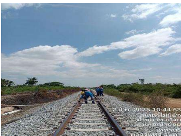
รูปที่ 1-132 งานตรวจวัดค่าความคลาดเคลื่อนรางรถไฟ กม.134+000
