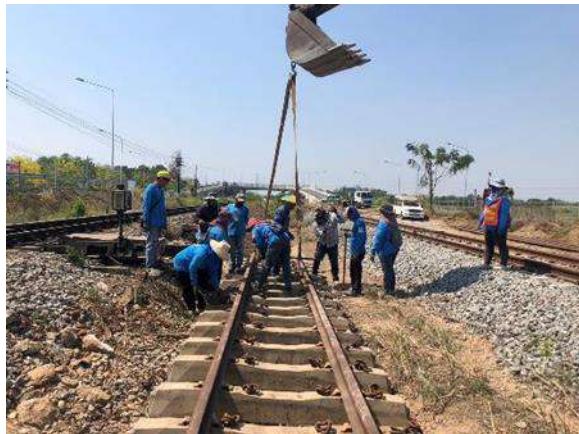
รูปที่ 1-56 งานวางหมอนคอนกรีต วางรางรถไฟ
