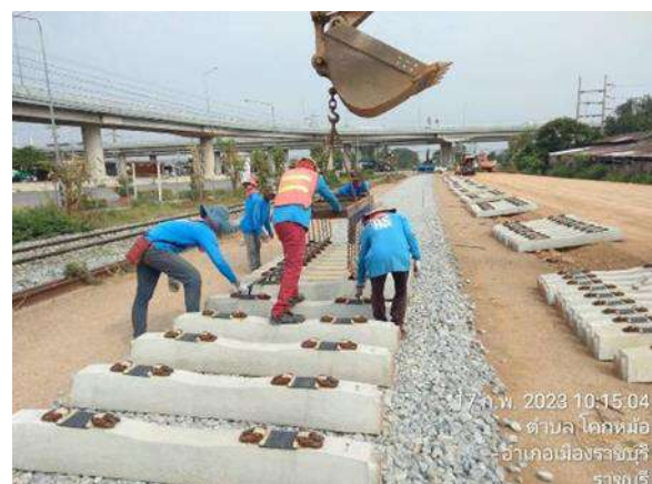
รูปที่ 1-30 งานลงหิน Ballast วางหมอนหมอนคอนกรีต
