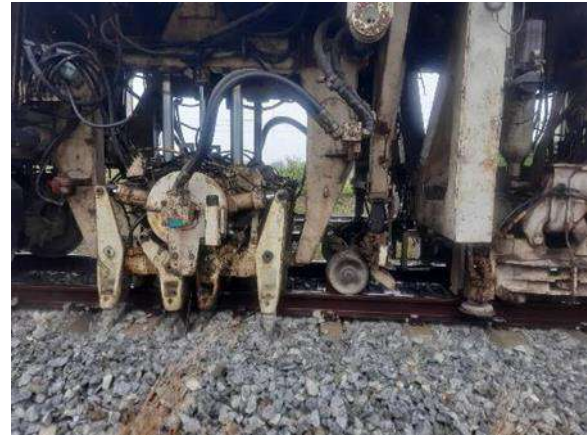
รูปที่ 1-105 งานบดอัด Ballast และจัดระดับทางรถไฟ
