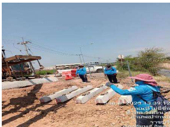
รูปที่ 1-76 งานวางหมอนคอนกรีต วางรางรถไฟ
