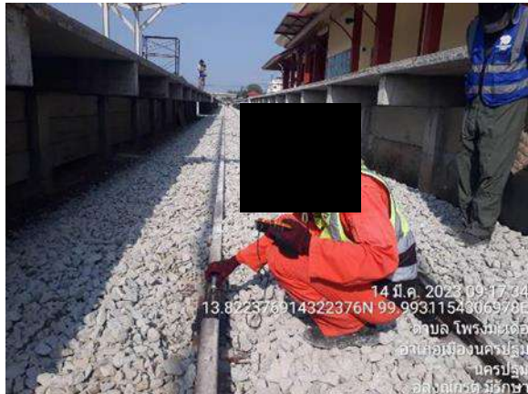
รูปที่ 1-54 งานตรวจ Ut test กม.55+000
