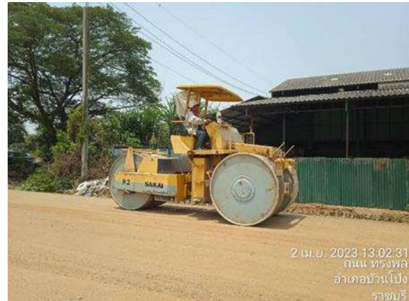
รูปที่ 1-73 งานบดอัด Base course ทางขึ้น-ลงสะพาน U-Turn Road กม.67+600
