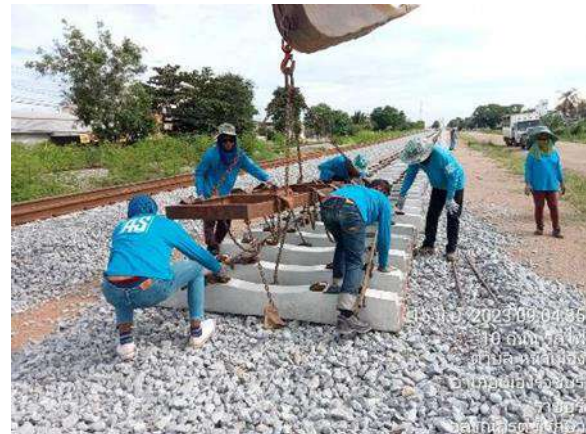
รูปที่ 1-135 งานวางหมอนคอนกรีต
