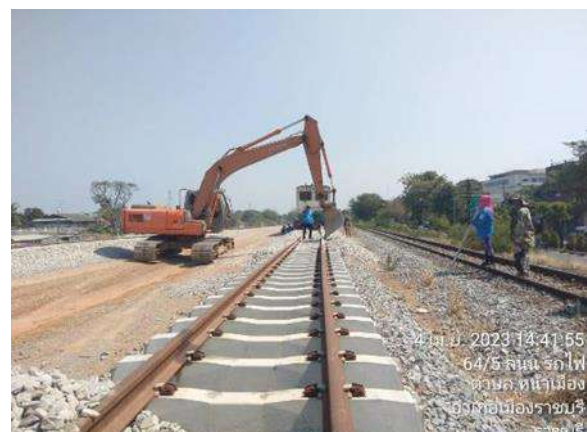
รูปที่ 1-76 งานวางหมอนคอนกรีต วางรางรถไฟ
