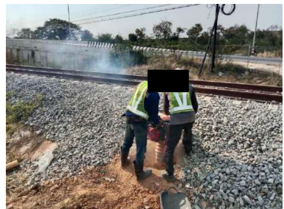
รูปที่ 1-164 ท่อร้อยสายลอดใต้ทางรถไฟ UTX และ Main Cable Pit บริเวณย่านสถานี
