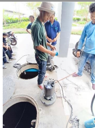
ภาพที่ 2.2-24 เจ้าหน้าที่ตรวจสอบบำรุงรักษาระบบบำบัดน้ำเสีย
