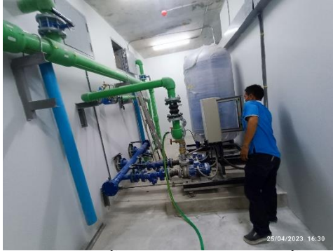
ระบบท่อน้ำปะปาก่อนเข้าถึงเก็บน้ำ
