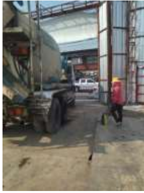
รูปที่ 6 เจ้าหน้าที่ล้างทำความสะอาดล้อรถบรรทุกก่อนออกจากโครงการ
