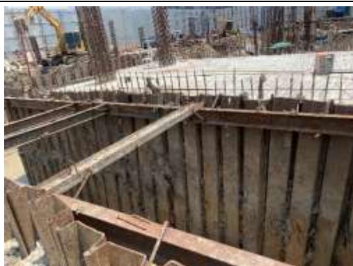
รูปที่ 4 ติดตั้ง Sheet Pile ป้องกันการพังทลายของดิน
