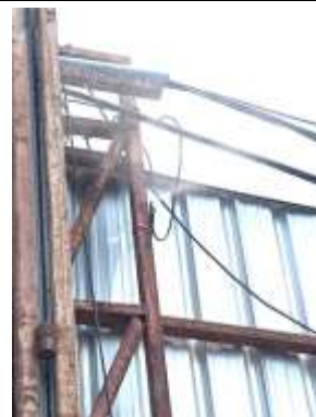
รูปที่ 26 สเปร้น้ำอัตโนมัติ
