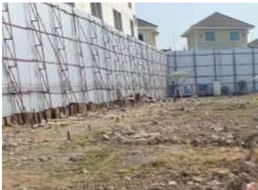
รูปที่ 1 ติดตั้งรั้ว Metal Sheet รอบพื้นที่ก่อสร้าง
