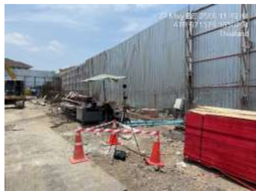
รูปที่ 36 ติดตั้งเครื่องตรวจวัดคุณภาพสิ่งแวดล้อม (คุณภาพอากาศ ระดับเสียง และความสั่นสะเทือน)
