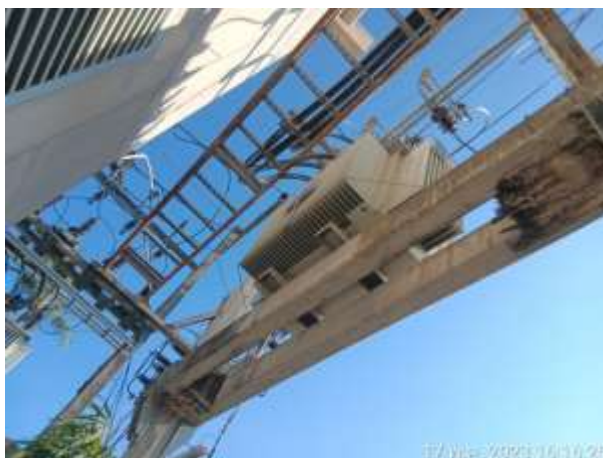
รูปที่ 2.26 หม้อแปลงไฟฟ้า และป้ายเตือนอันตราย
