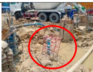
รูปที่ ผ7.31 เครื่องมือตรวจวัดการเอียงตัว (Inclinometer)
