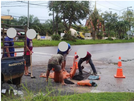
รูปที่ 30 การซ่อมแซมเส้นทางขนส่งแร่
