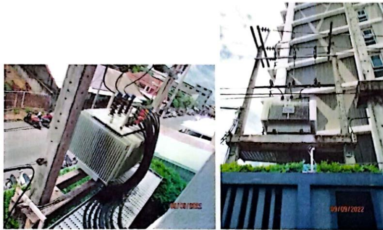
รูปที่ 6 แสดงหม้อแปลงไฟฟ้าขนาด 1500 KVA
