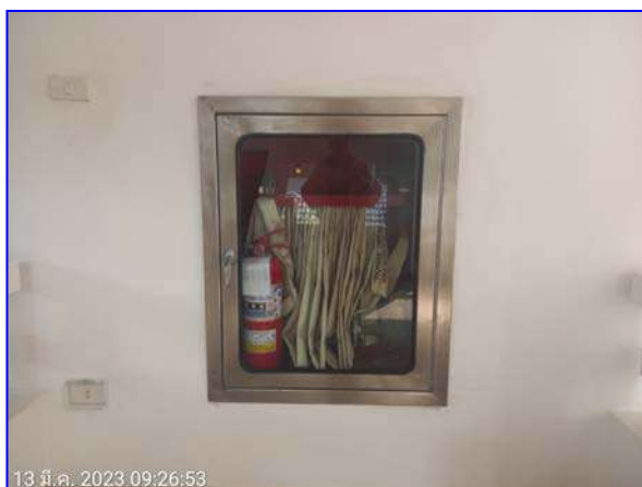
รูปที่ 2.28 ตู้เก็บสายฉีดน้ำดับเพลิง และถังดับเพลิง
