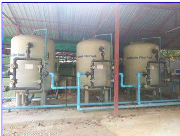
รูปที่ 2.3 ระบบกรองน้ำใช้หลักของโครงการ
