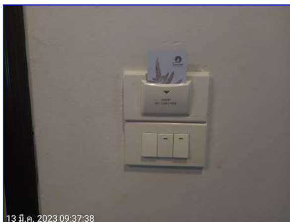
รูปที่ 2.24 ภูเขาตัดไฟอัตโนมัติในห้องพัก
