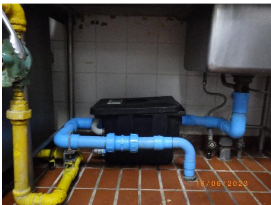
รูปที่ 2-21 ถังดักไขมันภายในห้องครัว
