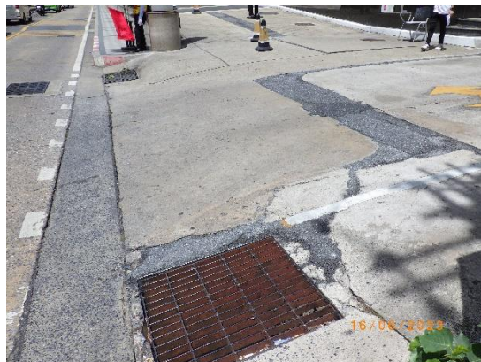
รูปที่ 2-32 รางระบายน้ำและตะแกรงดักขยะ ทางออกโครงการบริเวณซอยร่วมฤดี
