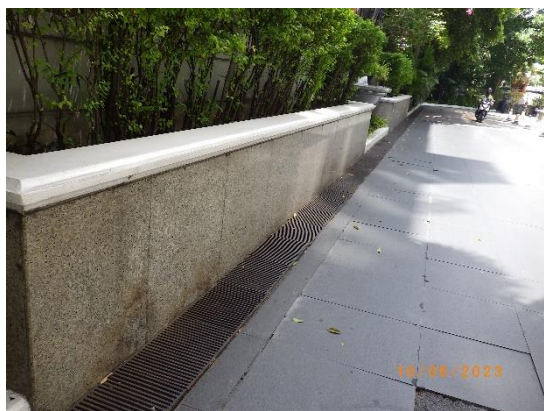
รูปที่ 2-28 รางระบายน้ำภายในโครงการฯ
