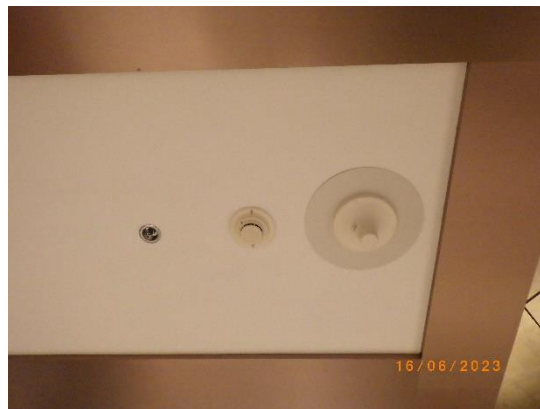
รูปที่ 2-44 อุปกรณ์ตรวจจับควันไฟ และความร้อน
