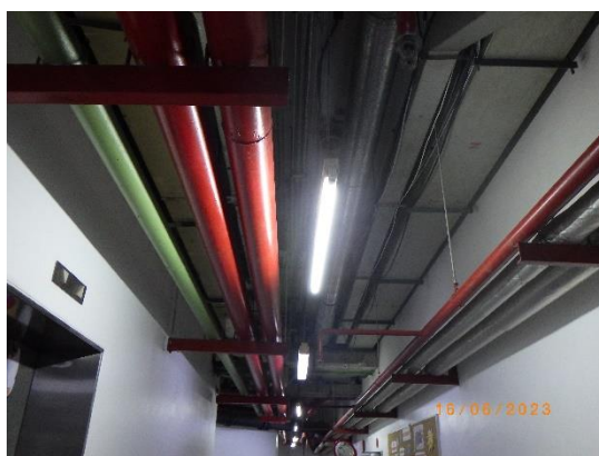
รูปที่ 2-47 ระบบท่อรับน้ำภายในอาคาร
