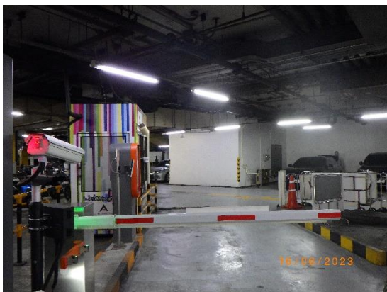
รูปที่ 2-9 ระบบบัตรอิเล็กทรอนิกส์ ให้รถผ่านเข้า-ออก โครงการฯ
