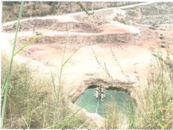
รูปที่ 7 พัฒนาพื้นที่รับน้ำขุ่นข้นและตะกอนดิน (Sump) ที่เกิดจากการชะล้างบริเวณหน้าเหมือง
