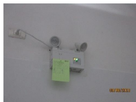
ไฟส่องสว่างสำรองฉุกเฉิน รูปที่ 2-10 (ต่อ) ระบบป้องกันอัคคีภัย
