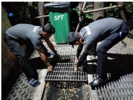
ตรวจสอบและทำความสะอาดรางระบายน้ำ
