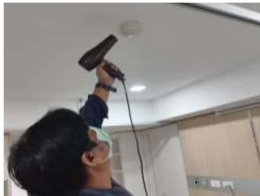
ภาพที่ 2.2-23 ตรวจสอบอุปกรณ์ป้องกันอัคคีภัย
