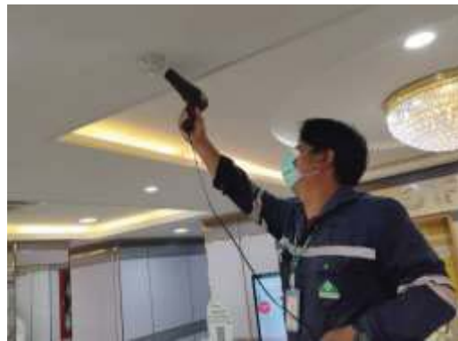
ภาพที่ 2.2-23 ตรวจสอบอุปกรณ์ป้องกันอัคคีภัย
