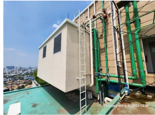
รูปที่ 17 ถังสำรองน้ำชั้นดาดฟ้า
